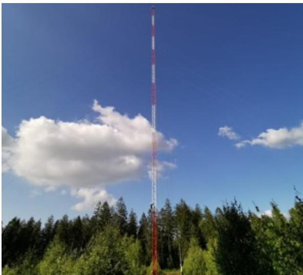
Fig. 8 : l'activité des chauves-souris et la qualité du vent ont été mesurées à l'aide d'un mât de mesure de 100 m de haut pendant 2 années.
